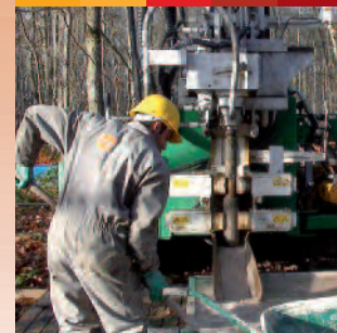
Suivi technique d'un forage.
