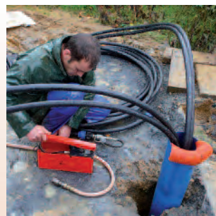
1/ Derniers contrôles d'installation d'une sonde géothermique. ©GEOforage49.
