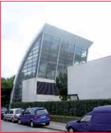
VUE EXTÉRIEURE DE LA CHAUFFERIE.
