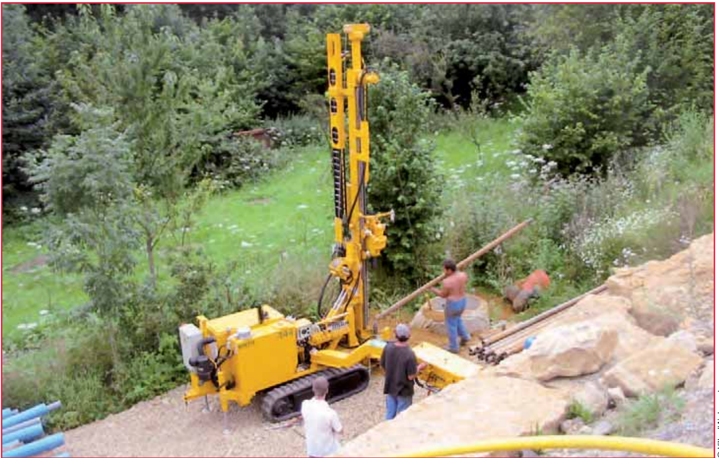
OPERATION DE FORAGE DE SONDES.
