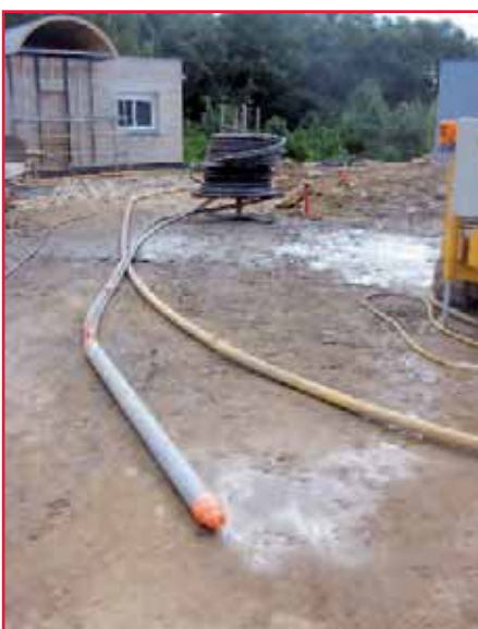
SONDES GEOTHERMIQUES AVANT MISE EN PLACE.
