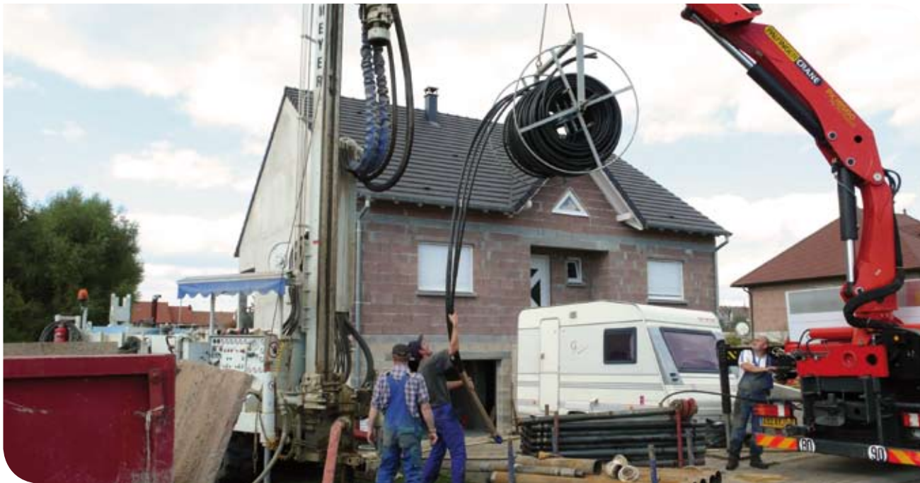
Mise en place d'une sonde verticale (GÉOFORAGE ALSACE)
