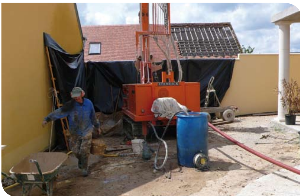
Forage d'eau – Entreprise CARNIS
