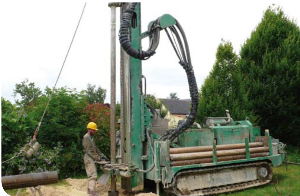
Forage d'eau – Van Ingen forages
