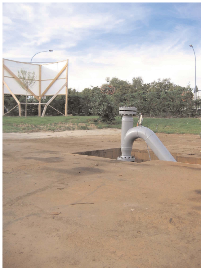
Tête de puits après travaux.
