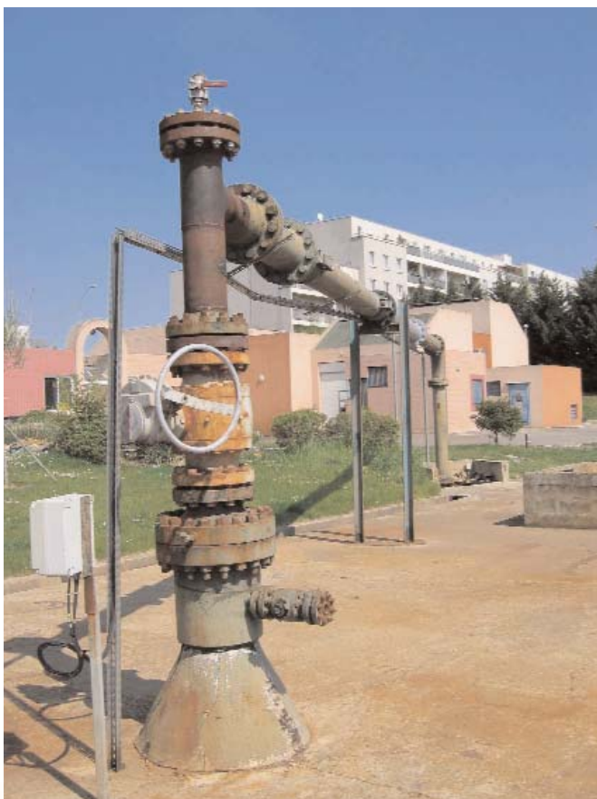
Tête de puits avant travaux.
