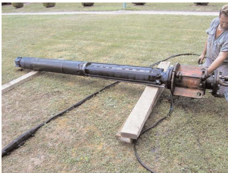
Maintenance de la pompe immergée
