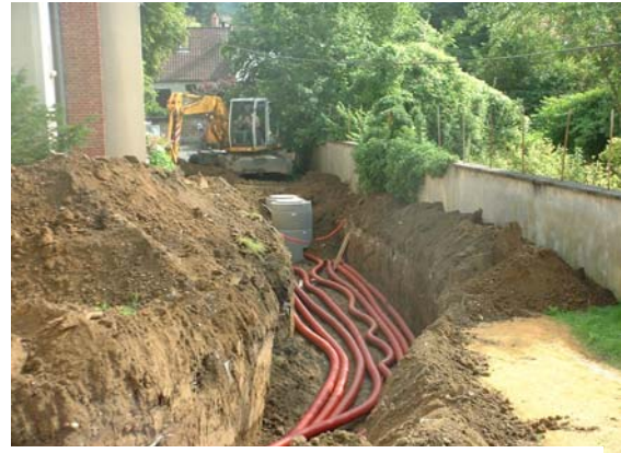
Réseau de puits canadiens avant remblaiement.
