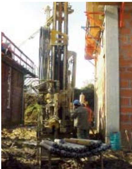
Réalisation du forage à 70 m de profondeur destiné à recevoir le tube où circule le fluide caloporteur.
