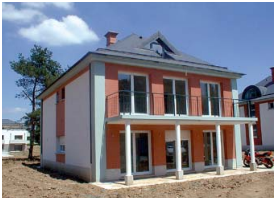
Cette réalisation est la première du genre en France en maisons individuelles groupées.
