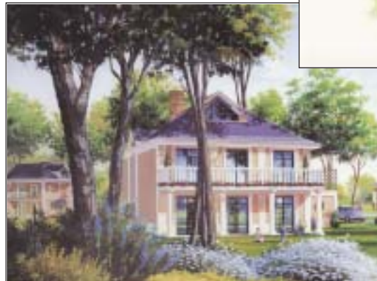
Ces maisons individuelles associent un plancher chauffant-rafraîchissant à des pompes à chaleur géothermales.
