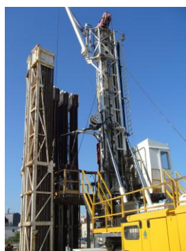
Chantier de forage au Fort d'Issy Crédit photo : Dalkia
